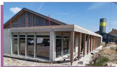
Construction d'une cantine et d'un accueil périscolaire
